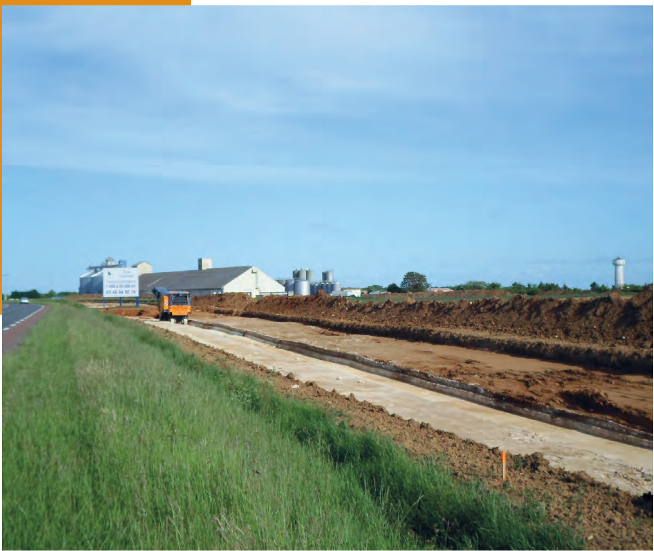
La communauté de communes a réalisé la 3 ème tranche de la zone des Grands Champs dans le 2 ème trimestre 2015. Elle a porté sur la viabilisation de près de 9 ha situés entre la déviation et la voie de chemin de fer. Les parcelles sont plus grandes que celles de la 2 ème tranche afin de proposer une offre élargie aux entreprises qui souhaitent se développer.
